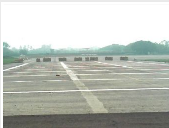
加鋪柔性鋪面前封閉反射裂縫
