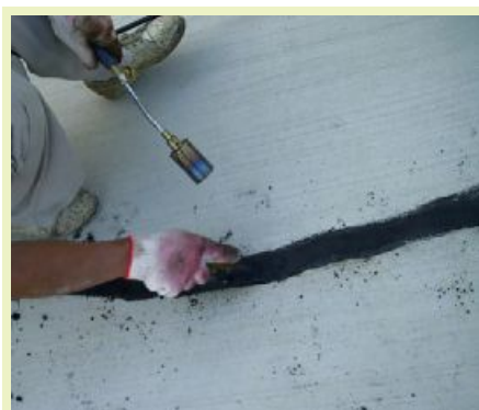
填補適量 512 填縫骨材
