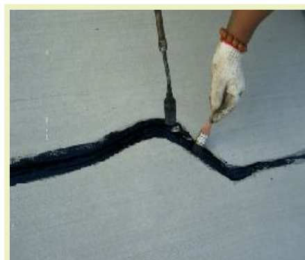
熔滲填縫劑封閉裂縫
