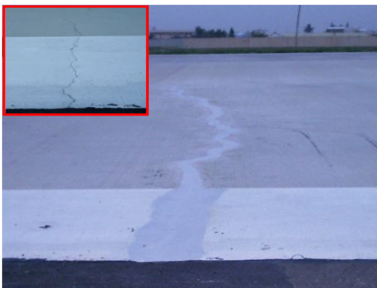
剛性鋪面裂縫修補
