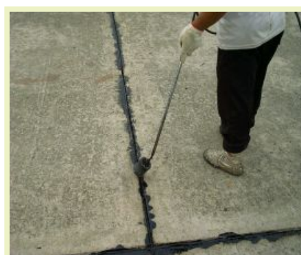
熔滲填縫劑封閉槽縫
