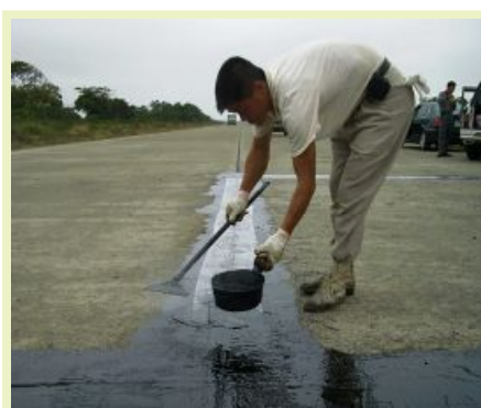
填縫劑封蓋接合新面層
