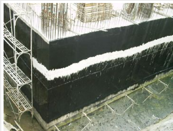
新建地下室壁面灌筑接缝、蜂巢防水
