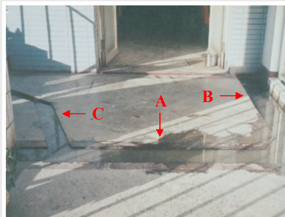
走廊 A 伸缩缝、B 接缝、C 裂缝积水验收
