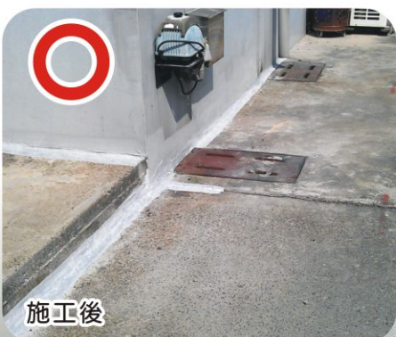
熔滲接縫建立多層防水防護層
