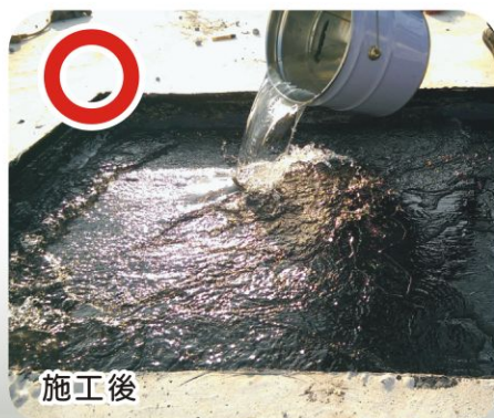
局部開鑿漏水區域熔滲裂縫建立防水層
