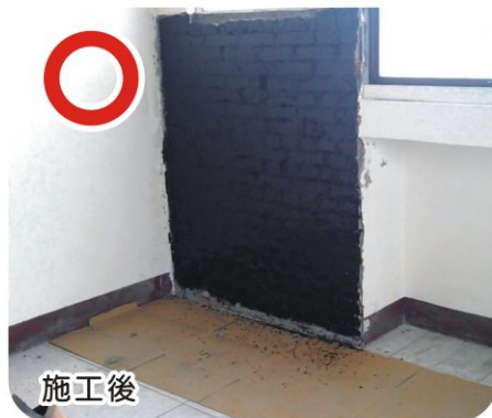
熔滲牆面全面封閉進水路徑
