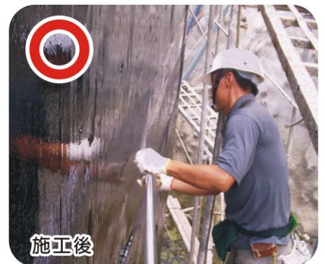
全面熔滲達成新建壁體完整防水防護
