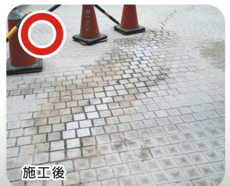
局部開鑿裂縫熔滲修補裂縫建立防水層
